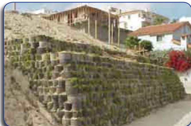
Whole tire wall used to impede soil erosion Photo courtesy of La Comisión Estatal de Servicios Públicos de Tecate
